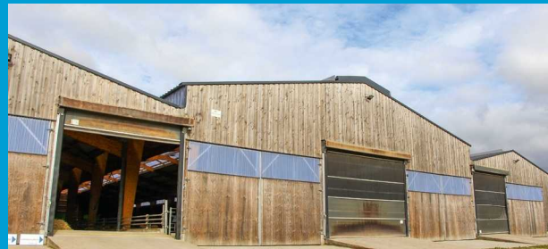
Pour qu'il ne soit pas trop haut, le bâtiment a été conçu en trois chapelles, avec trois couloirs d'alimentation et 600 places de cornadis. ©V. Bargain
